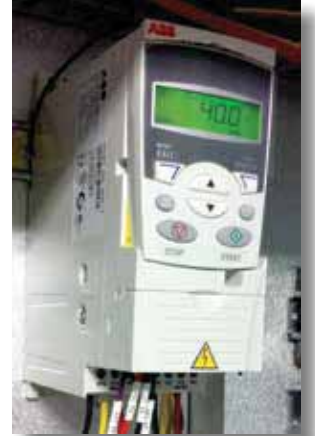
Supply Fan VFD - Standard
