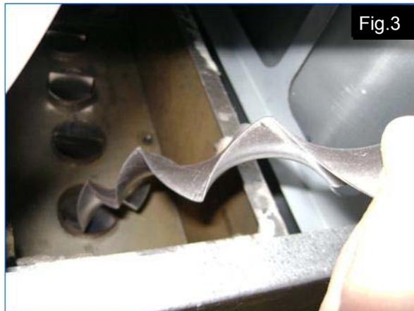
Nettoyer les tubes émetteurs à l'aide d'une brosse/ d'un grattoir appropriés, montés sur des tiges de rallonge flexibles.
