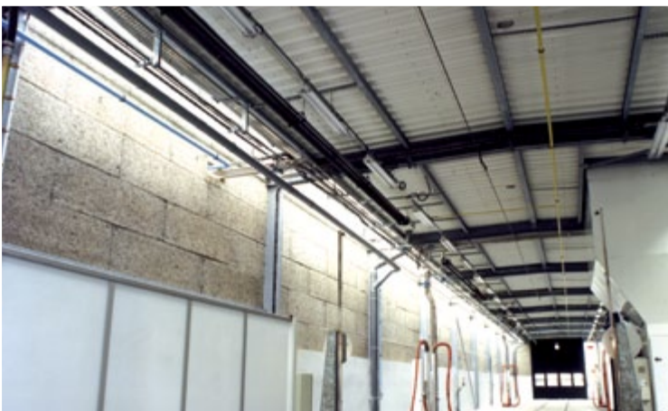
Stralers in een onderhoudswerkplaats voor openbaar vervoer
