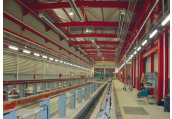
Atelier d'entretien ferroviaire
