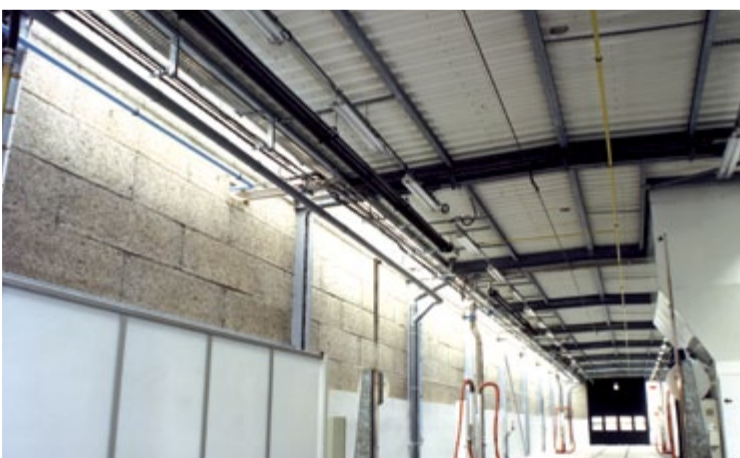
Des radiants dans un atelier d'entretien des transports en commun
