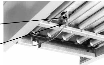
FIGURE 37 – Emplacement de veilleuse
