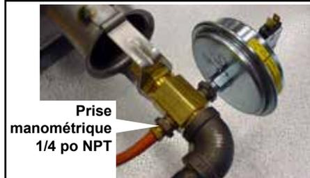
**AVERTISSEMENT: Mesurez la pression à allure minimale en ce point uniquement pour les appareils avec option de commande de gaz à modulation électronique AG8, AG9, AG9H, AG40, DG2, DG6 ou D12B).**
