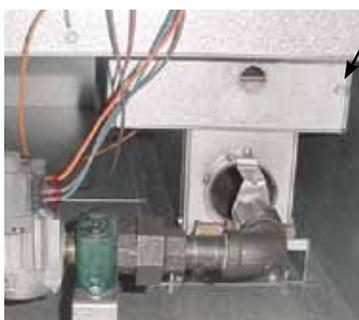
**Desserrer la vis pour déposer l'extrémité du capot du brûleur. La vis reste fixée au capot.**
