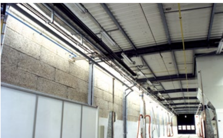
Instalacja promienników liniowych CERA w ośrodku sportowym; ich estetyczne wykończenie polepsza integrację wizualną w przestrzeni publicznej.
