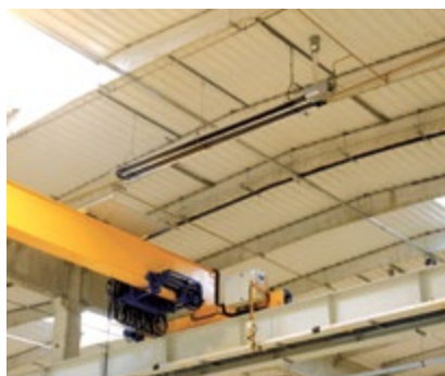
WRH: instalacja nad suwnicą
