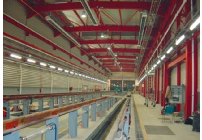
Zakład konserwacji kolei
