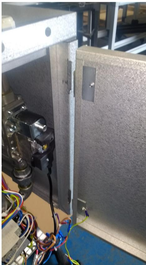
Enlever le couvercle inférieur s'il n'y a pas assez de place pour atteindre les composants du brûleur. Avant d'enlever les 4 vis en bas du couvercle il faut d'abord desserrer les contacts électriques des 2 lampes et du commutateur (voir fig. 11 et 12).
