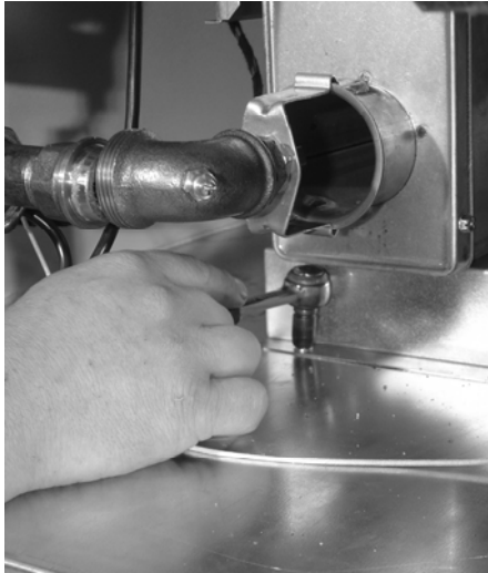
Figure 23 Déconnecter câble de la sonde de flamme sur le relais de flamme
