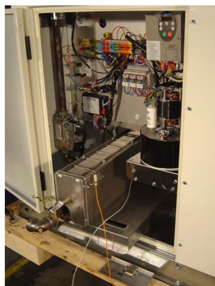
Figuur 24 Verwijder branderhuis, vlamvoeler en ontstekings- elektrode
