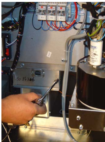
Figuur 17 Verwijder de 2 moeren van het hitteschild
