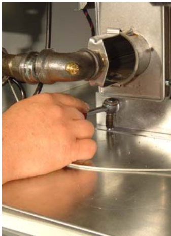
Abbildung 21 (Brennerkonsole lösen)
