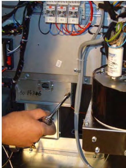
Figuur 17 Verwijder de 2 moeren van het hitteschild
