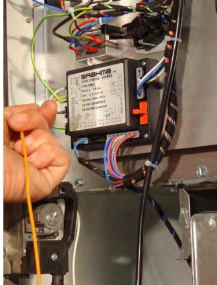
Figuur 22 Ontkoppel aan de branderautomaat de bedrading van de ontstekingselektrode
