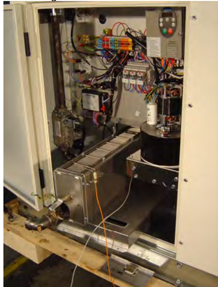
Figuur 24 Verwijder branderhuis, vlamvoeler en ontstekingselektrode
