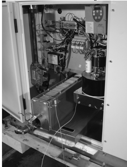
Figure 24 Enlever le corps du brûleur, la sonde de flamme et l'électrode d'allumage
