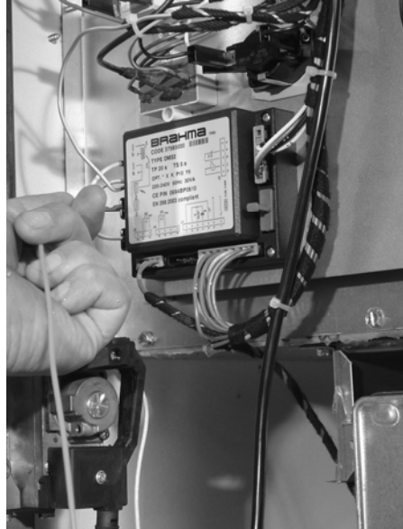
Figure 22 Déconnecter câble de l'électrode d'allumage sur le relais de flamme
