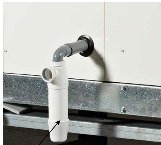
Siphon de condensat (n° de l'option = OP928)
