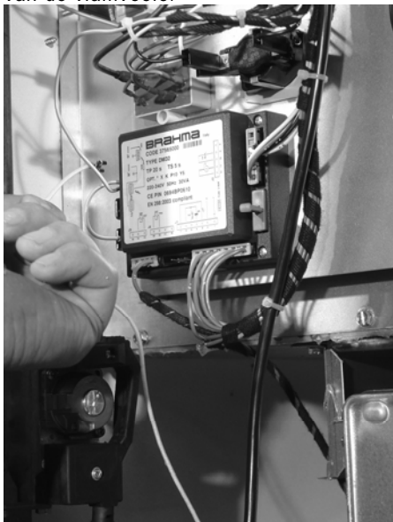
Figuur 23 Ontkoppel aan de branderautomaat de bedrading van de vlamvoeler
