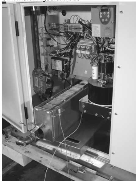
Figuur 24 Verwijder branderhuis, vlamvoeler en ontstekingselektrode
