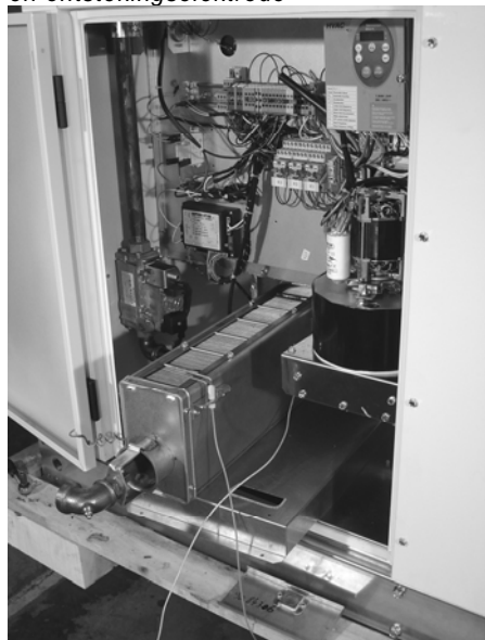
Figuur 24 Verwijder branderhuis, vlamvoeler en ontstekingselektrode
