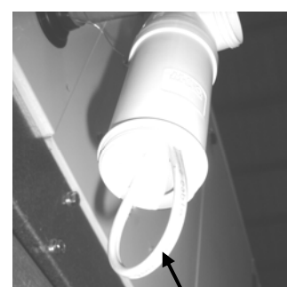
Elektrische warmteweerstand geplaatst in condensafvoerbus
