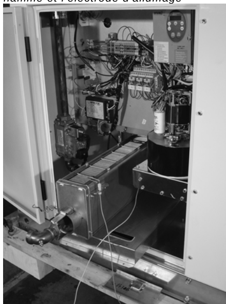
Figure 24 Enlever le corps du brûleur, la sonde de flamme et l'électrode d'allumage
