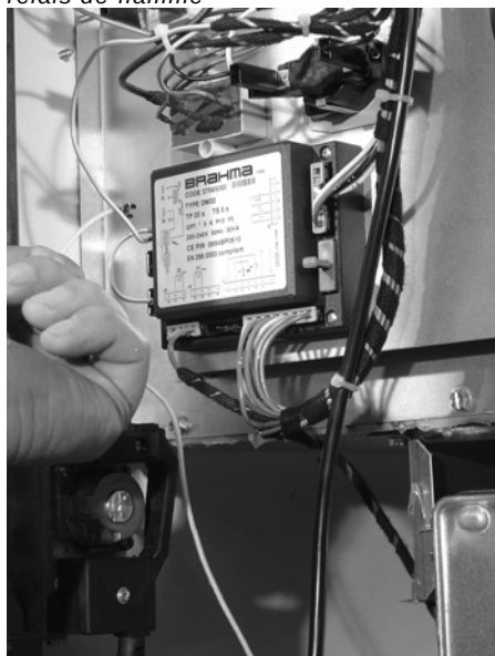
Figure 23 Déconnecter câble de la sonde de flamme sur le relais de flamme
