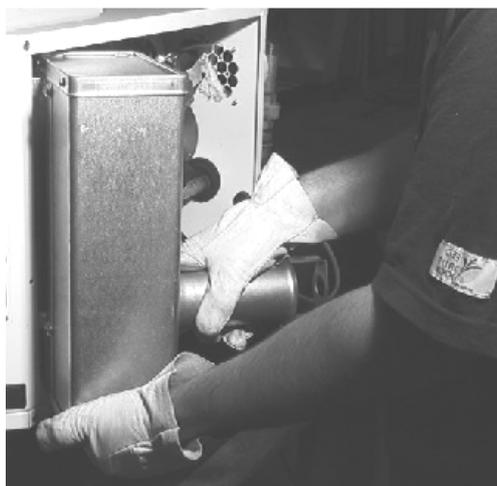
**Figure 14 : Procédure pour démonter le brûleur**
