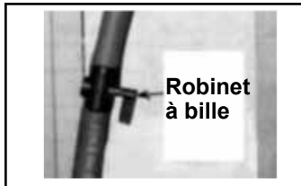
FIGURE 18 – Couper l'alimentation électrique et régler le débit d'eau à l'aide du robinet à bille.
