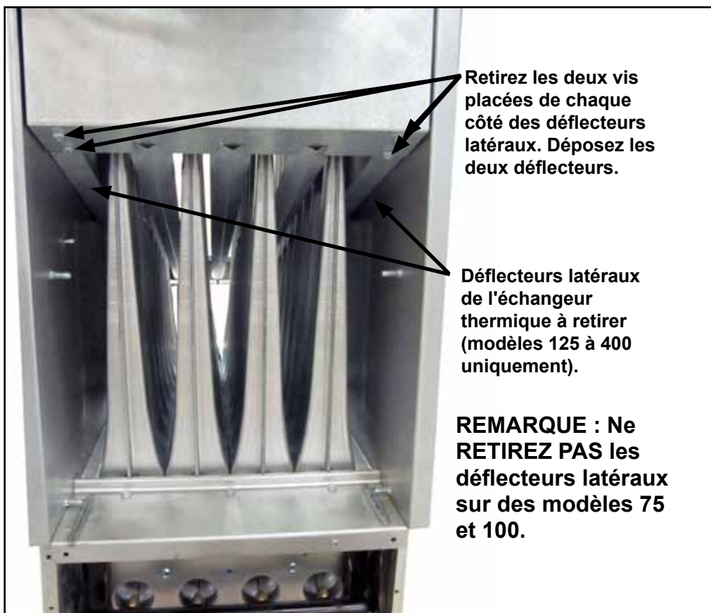
FIGURE 29 – Extrémité d'admission d'air de l'échangeur thermique illustrant les déflecteurs latéraux à retirer
