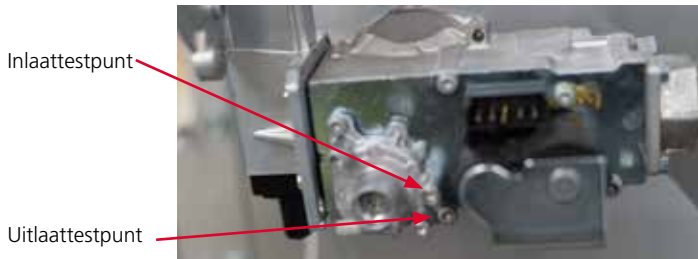
Gasdruktestpunten Photon 10-70
