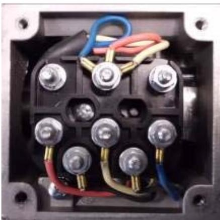
Raccorder les 3 phases sur U1 / V1 / W1
